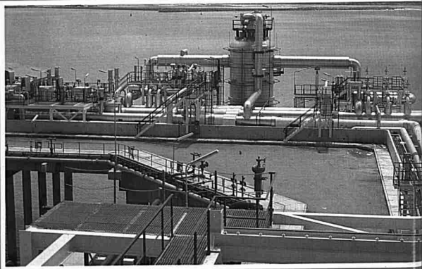
Aerial views of the LNG plant.
