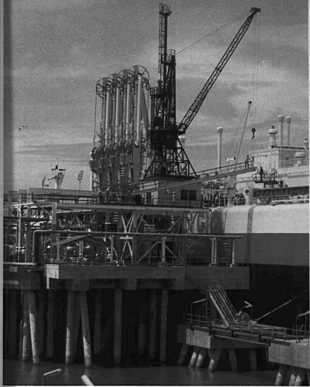
Close-up view of the LNG loading terminal.
